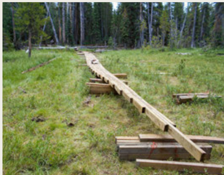
Abgehoben. Die «Trail Crew» baut einen Steg über den Sumpf im Stillwater Basin.
